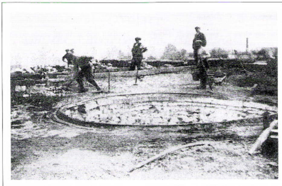
Travail au-dessus d'un four à chaux. (Photo prise entre les deux guerres mondiales). Les ouvriers déversent alternativement pierres et charbon dans la gueule du four.
