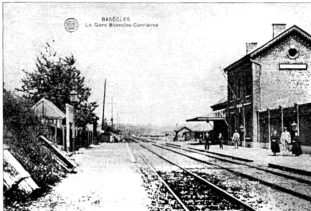
La gare de Basècles-Carières. Sur le bas-côté, à gauche, on peut apercevoir deux coffres en bois destinés à assurer la protection des tranches de marbre lors de leur transport.
