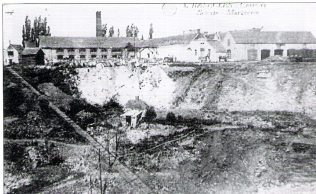
Vue d'une carrière avec scierie et marbrerie dans la partie supérieure. Le pompage des eaux souterraines permettait le travail "à sec" au fond de l'excavation.
