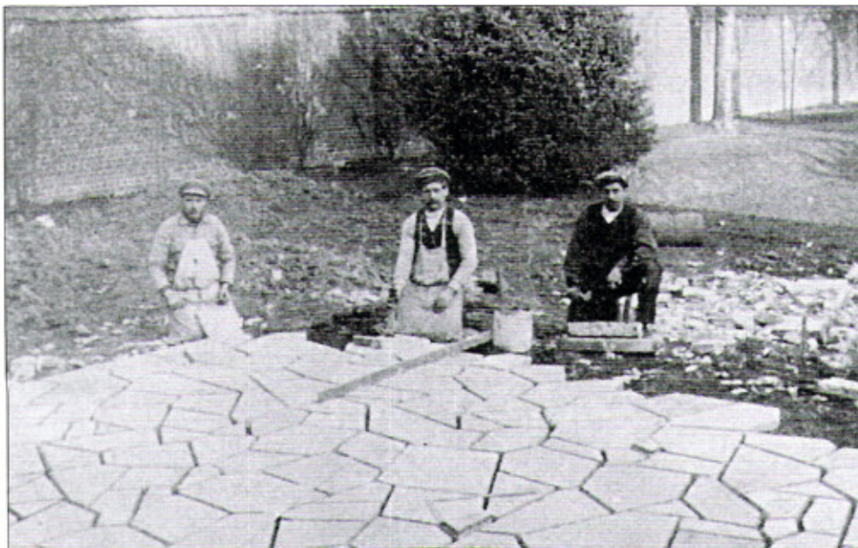
Ouvriers occupés à la pose de dalles en pierre.
