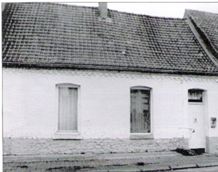
Petite maison de la rue O. Bataille datant de la fin du XVIIIe siècle. La façade, construite en moellons (pierres) de Basècles, est chaulée.
