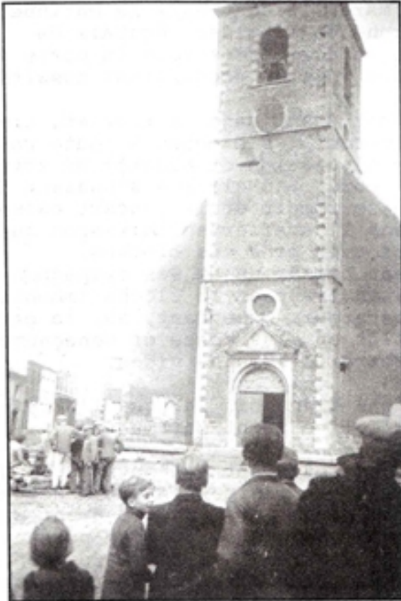
Les abat-sons ont été enlevés. Par une fenêtre béante de la tour, deux ouvriers surveillent la descente de la cloche tandis qu'en bas des hommes actionnent le treuil, sous les regards des curieux.
