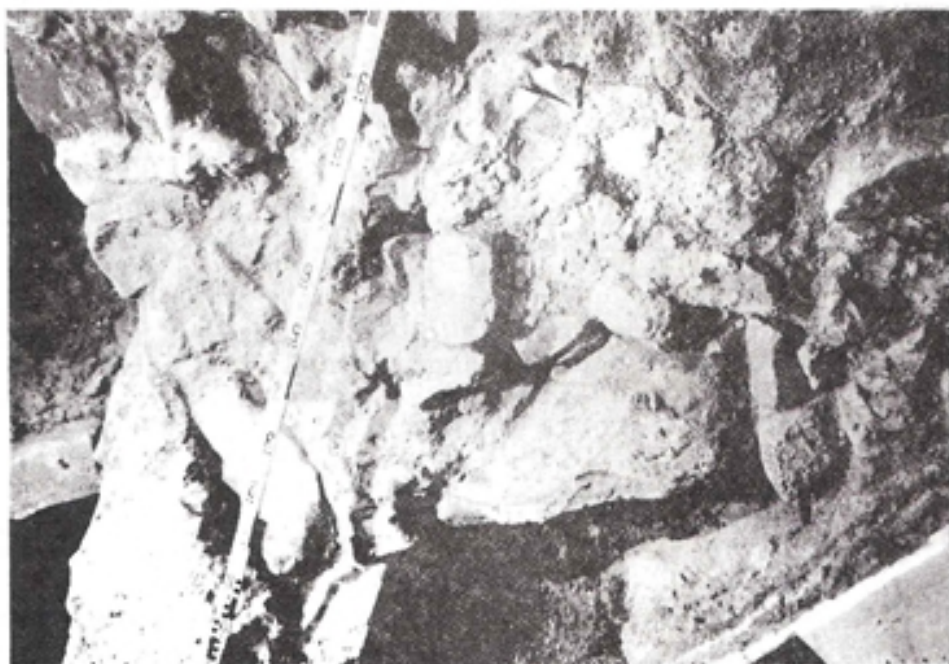
Jonction du mur du chœur (XVIIe S.) et du mur le plus ancien (moyen âge).
